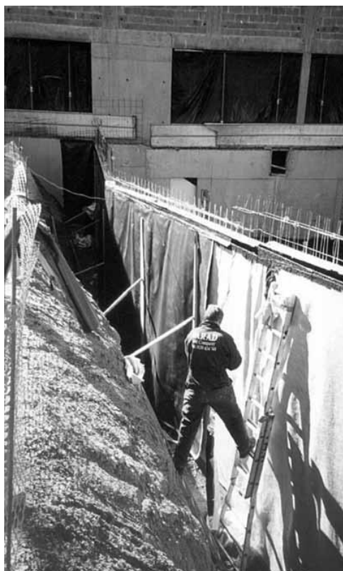
Figura 14: Colocação de telas anti-radônio nas paredes.
