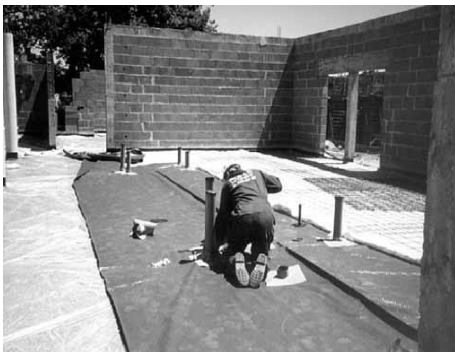
Figura 15: Colocação de telas anti-radônio no pavimento em contato com o solo.
