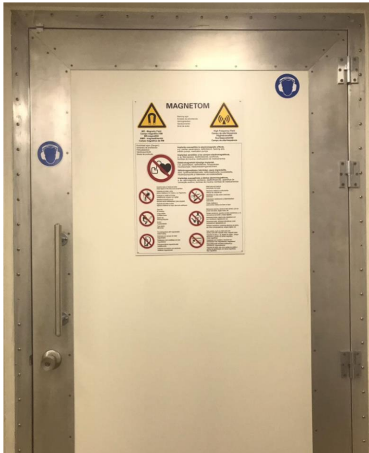
Figura 16 - Sinalização de contraindicação na porta da sala de exame da Ressonância Magnética
