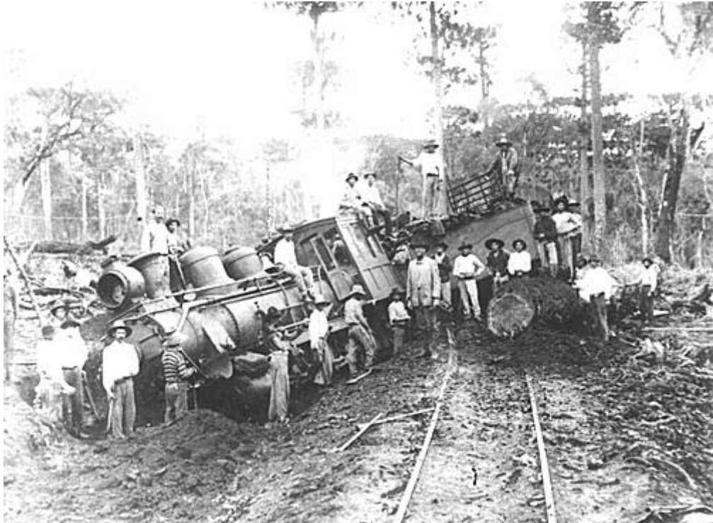
Trem descarrilhado após os caboclos destruírem trecho da ferrovia.
